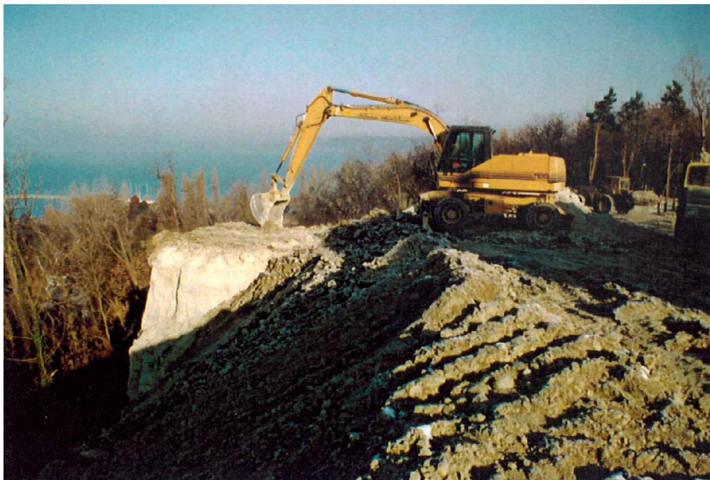
6. kép A Borozó feletti partél 50-60°-os rézsűs felszínrendezése az 1997. évi tömbös leszakadás után
