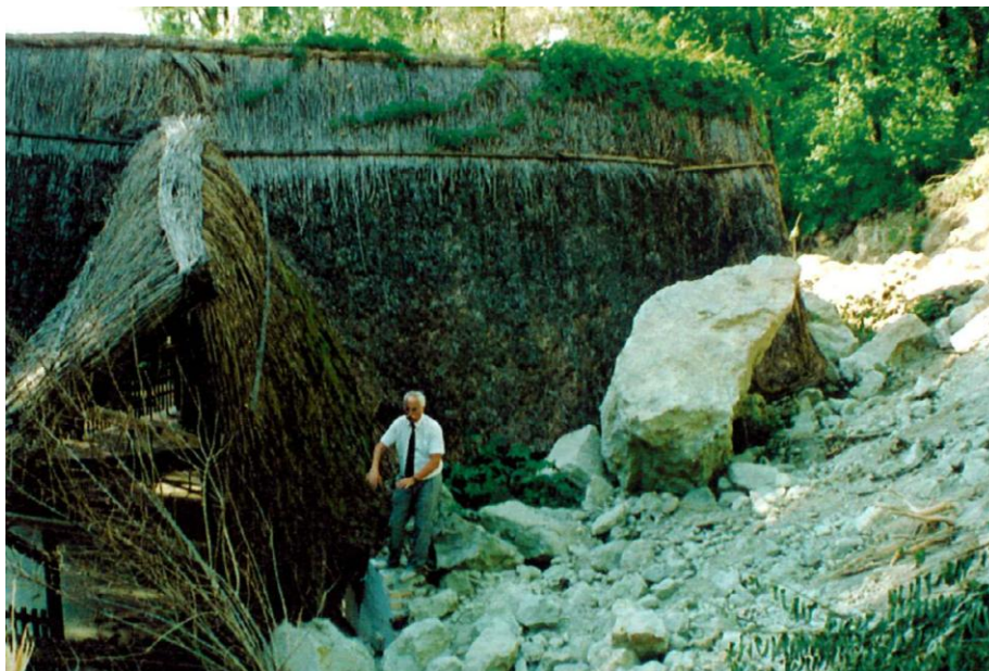
2-3. képek A partfal tömbös leszakadása 1997-ben a Borozó mögötti partfal szakaszon
