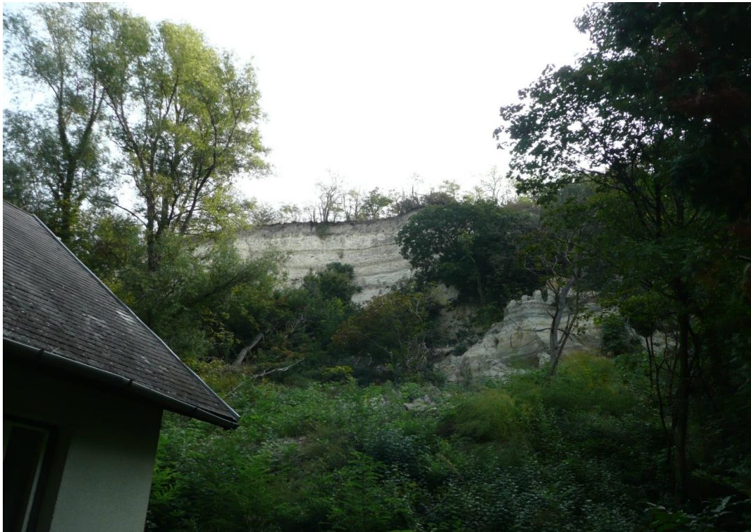
1. kép Tömbös leszakadás nyoma és a megmaradt partfal a XVI. villa mögött
